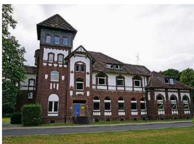
Das denkmalgeschützte Gebäude im Campus Fichtenhain wird Sitz von Dr. Heilmaier & Partner. Foto: GKG
