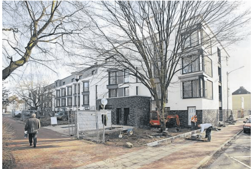
Im April sollen die ersten Bewohner in das neue Seniorenheim an der Gutenbergstraße einziehen. Foto: Dirk Jochmann
